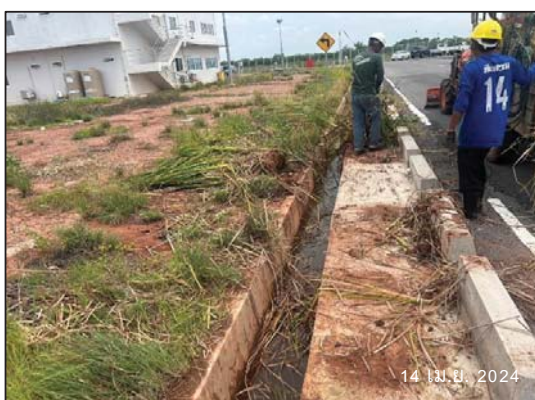
รูปที่ 2.2-16 การทำความสะอาดรางระบายน้ำ
