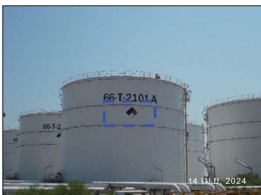
รูปที่ 2.2-21 ป้ายสัญลักษณ์แสดงอันตราย บนถังน้ำมัน
